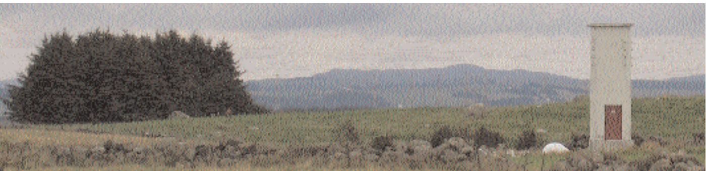
Transformatorkiosk på Obrestad.
