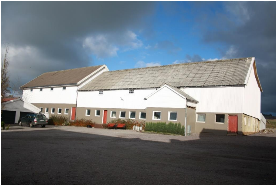
Driftsbygningen blir framleis halden vedlike, og den er i god stand. Men det er ikkje lenger husdyr i bygningen. Foto: Olav Magne Tonstad.
