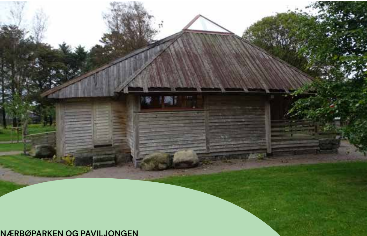
Paviljongen i Nærbøparken er laga etter sivilarkitekt Per Line sine teikningar datert 1996, oppført i 2005. Foto: Hå kommune, 2021.
