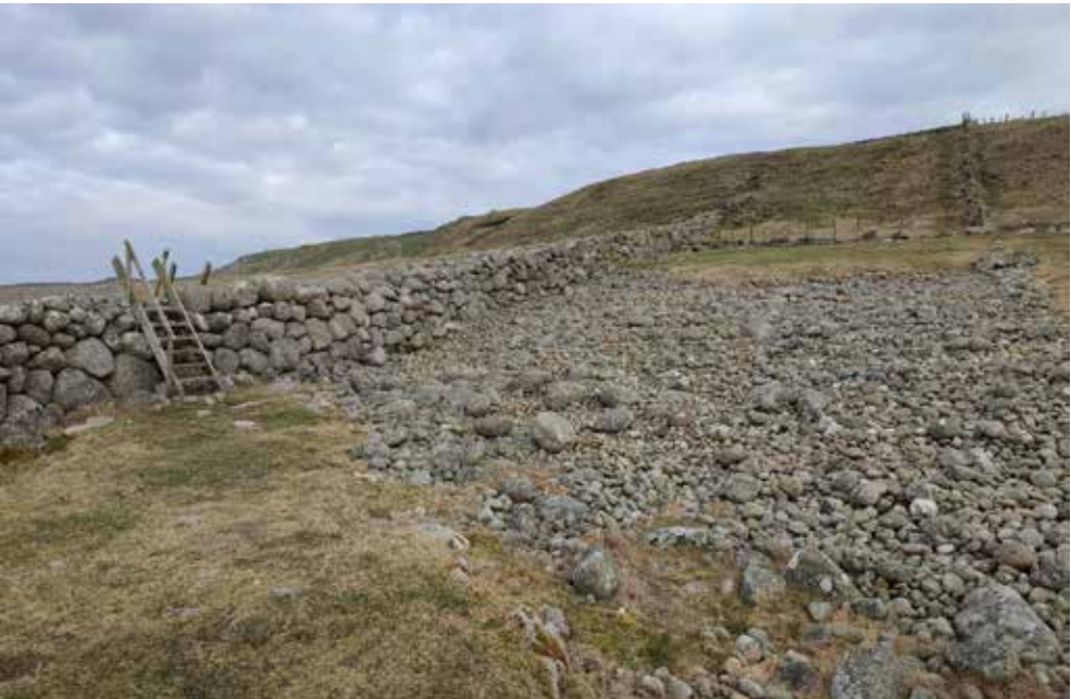
På begge sider av Stavnheimsvika ligg to store steingjerde bygd under krigen som tankssperre for å hindra ferdsel på tvers av stranda. Foto: Hå kommune, 2022.
