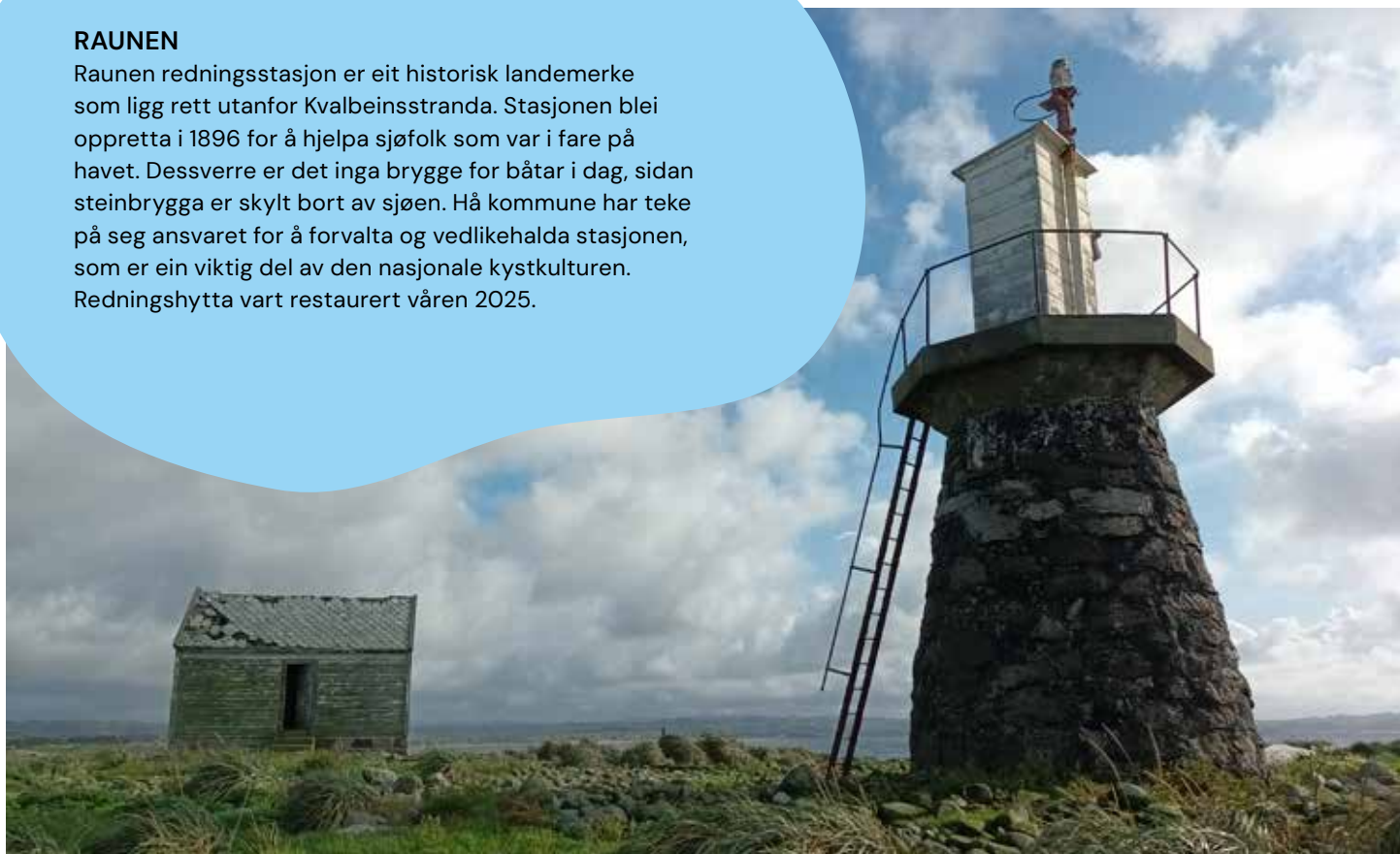
Raunen redningstasjon før restaurering. Foto: Hå kommune, 2023.
