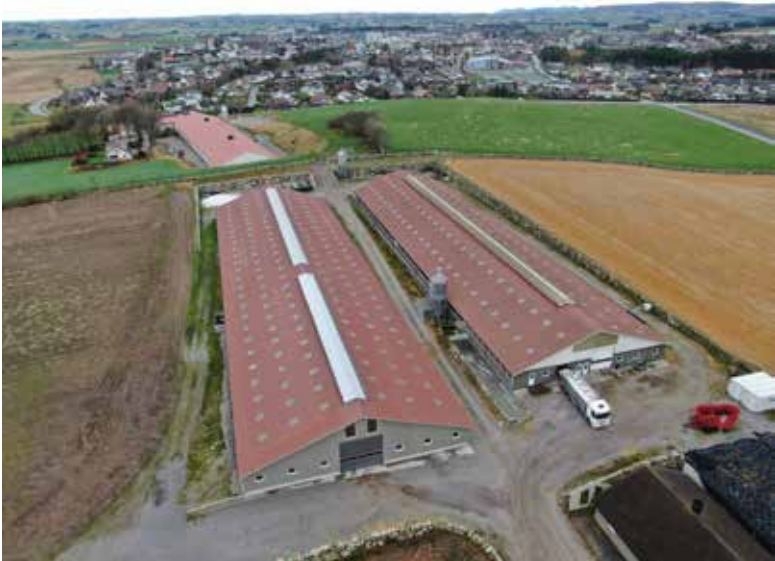
Stordriftsbygningar på Kvia. Foto: Hå kommune, 2021.
