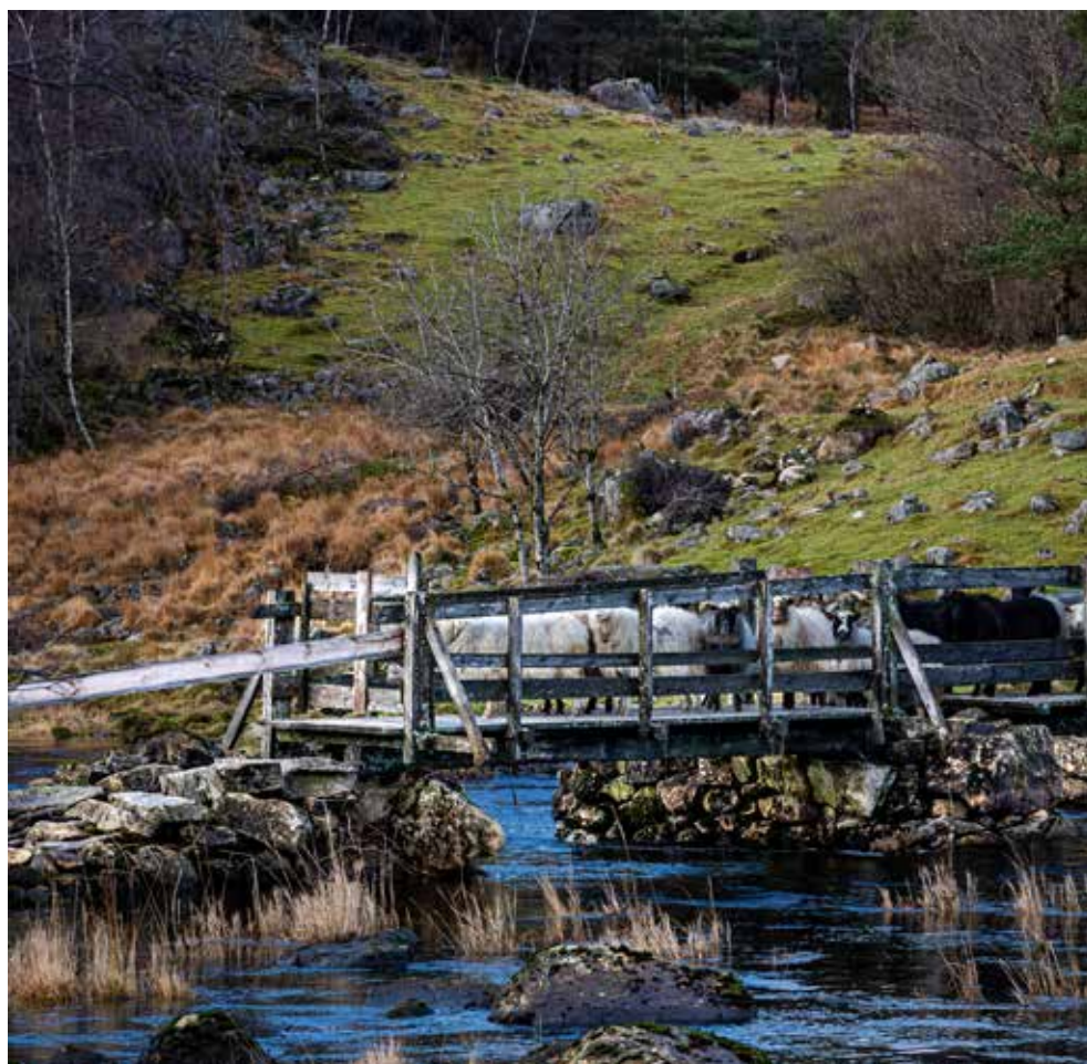
Øvrabø bru. Foto: Markus Bjørnseth, 2022
