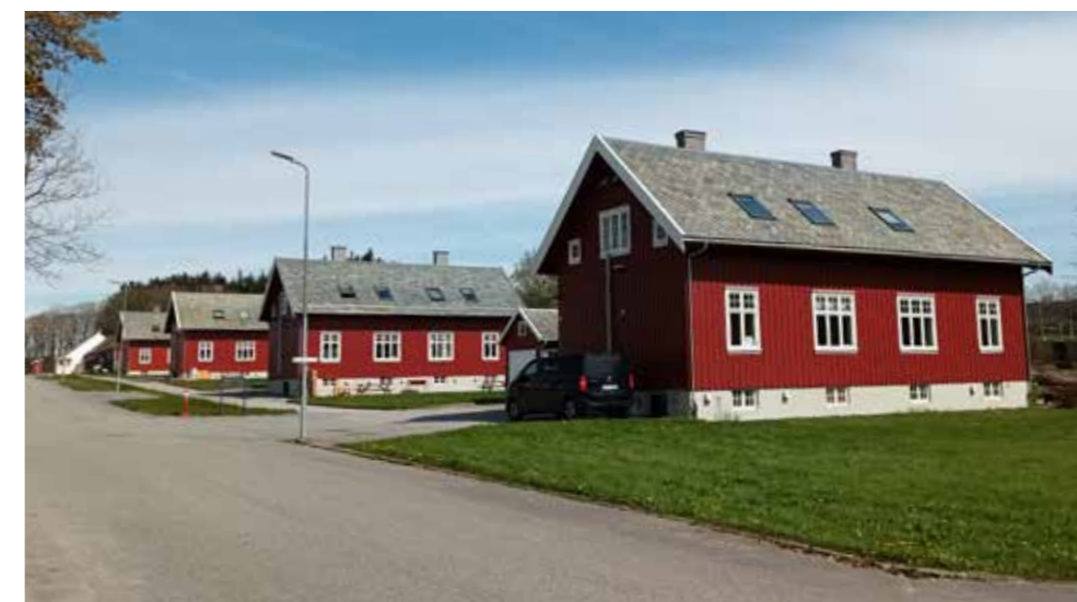
Rødgata med hagar. Oppført i 1918. Fasadar mot sør. Foto: Hå kommune, 2022.
