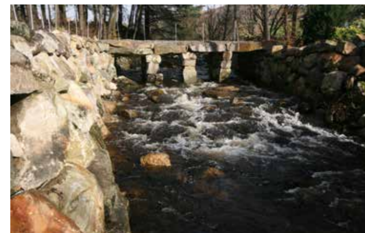
Steinbrua på Aniksdal etter restaurering. Foto: Hå kommune, 2018.
