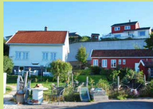
Restaurert Sandneskasse og løe i Sirevåg. Foto: Hå kommune, 2020.
