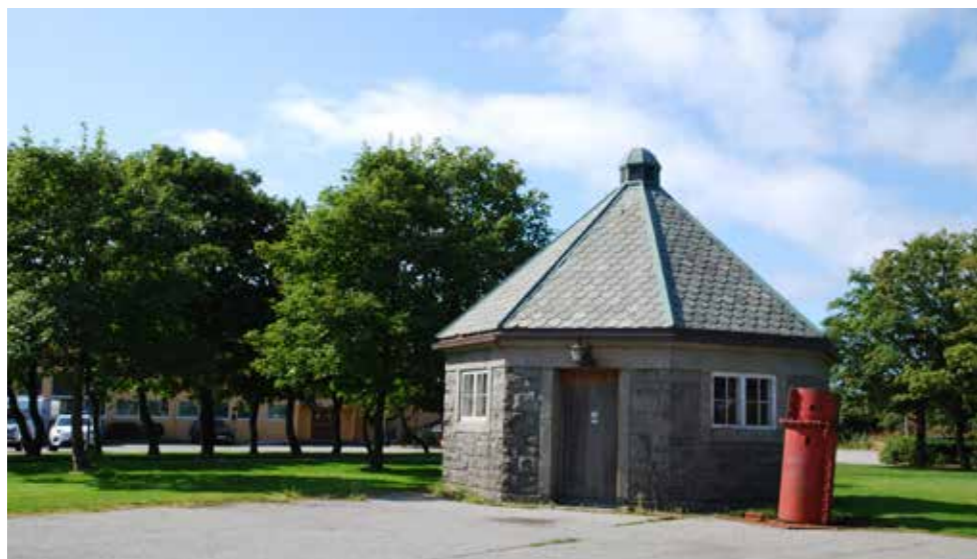
Akkumulatorhus. Foto: Hå kommune, 2021.
