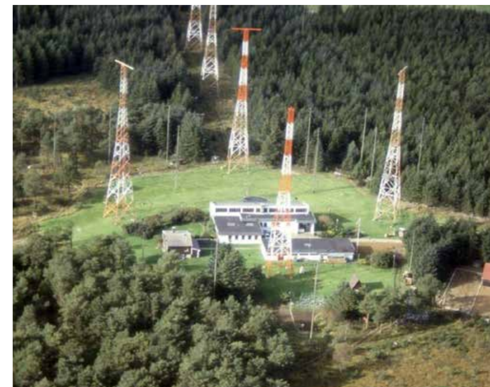
Sendestasjon for Rogaland radio i Vigreskogen. Foto: Telemuseet, ca 1975.
