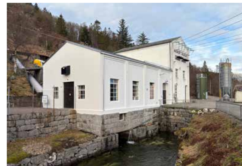
Hetland kraftverk på Oгна etter oppussing av fasaden i 2023. Foto: Hå kommune, 2024.
