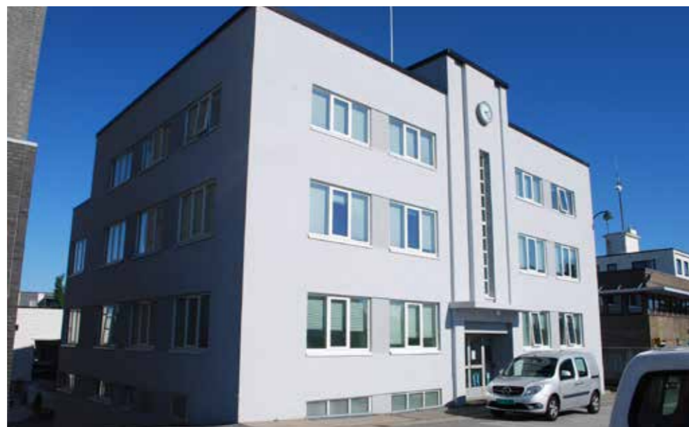
Eit godt eksempel på funksjonalisme i Hå kommune er Nærbø heradshus etter restaureringa. Foto: Hå kommune, 2021.
