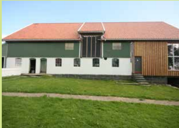
Løa på Brekkå under restaurering. Foto: Hå kommune, 2014.
