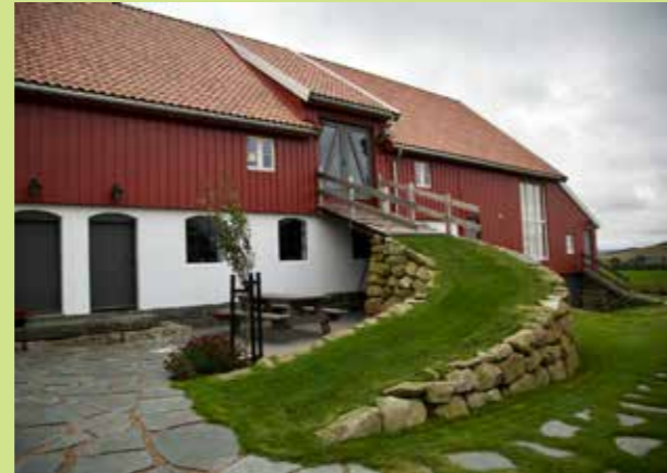
Løa på Brekkå etter restaurering. Foto: Lise Bjelland, 2021.
