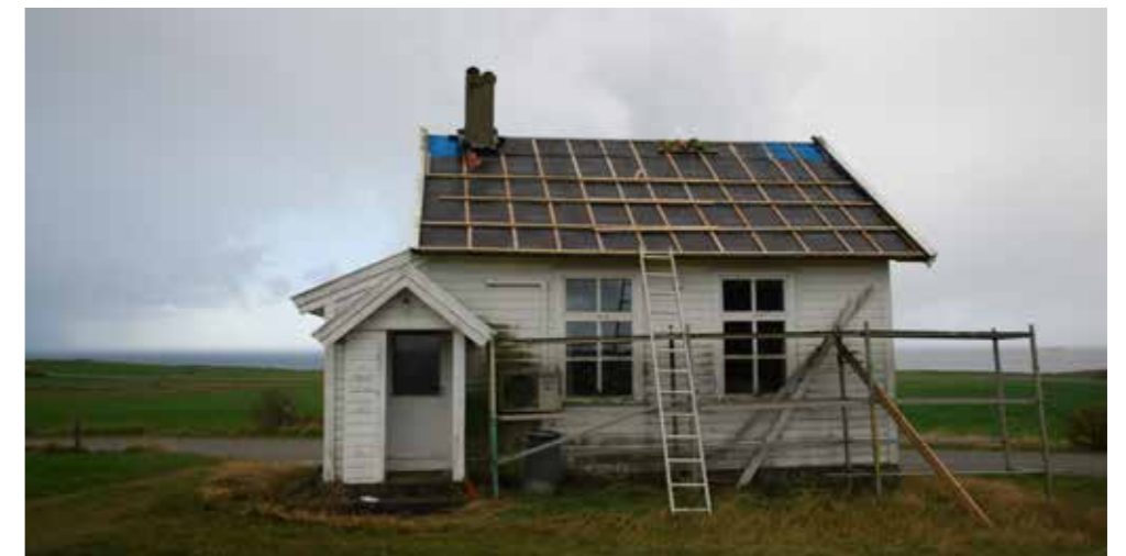
Stavnheim skulehus under restaurering. Foto: Hå kommune, 2020.
