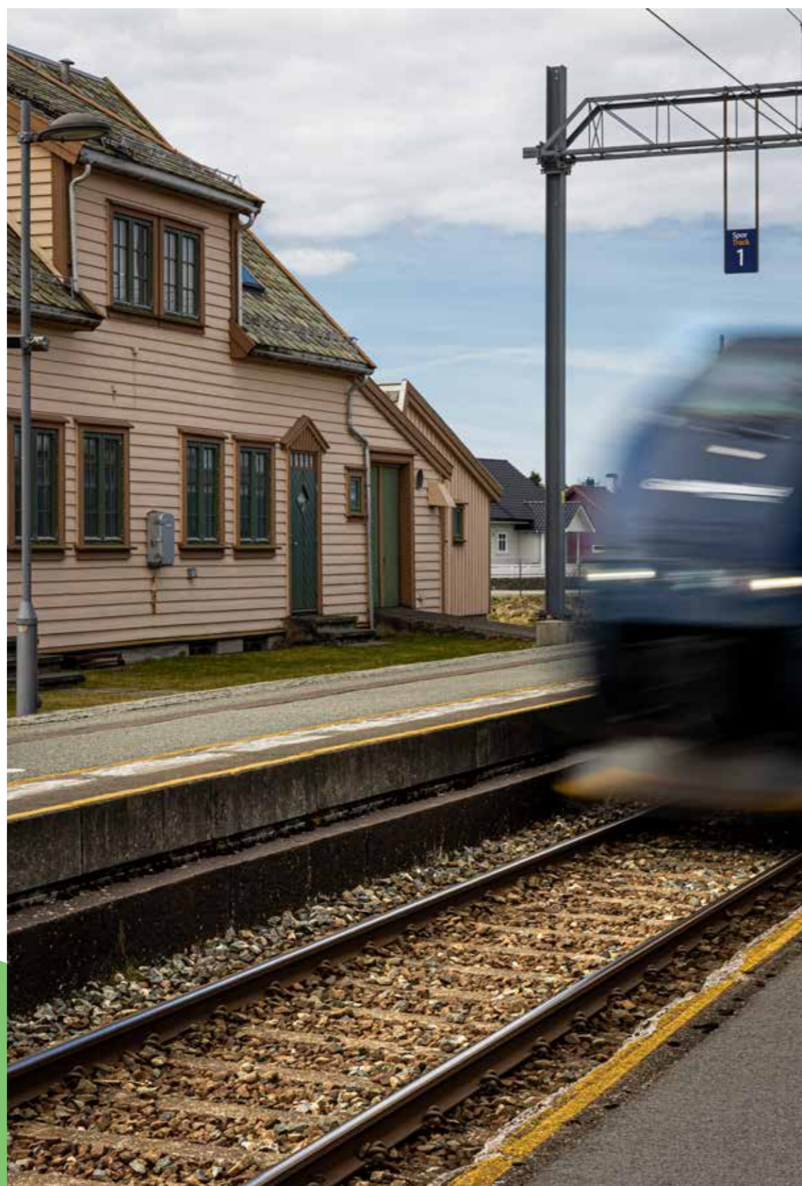
Brusand stasjon. Foto: Markus Bjørnseth, 2021.
