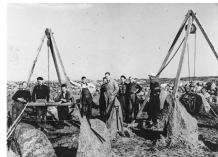
Arbeidarar som set opp Hitlertennene på Brusand i 1944. Me ser mellom anna to steinbukkar som blei brukt til å setja steinane på plass med. Foto: Hå bibliotek, fotosamlinga.
