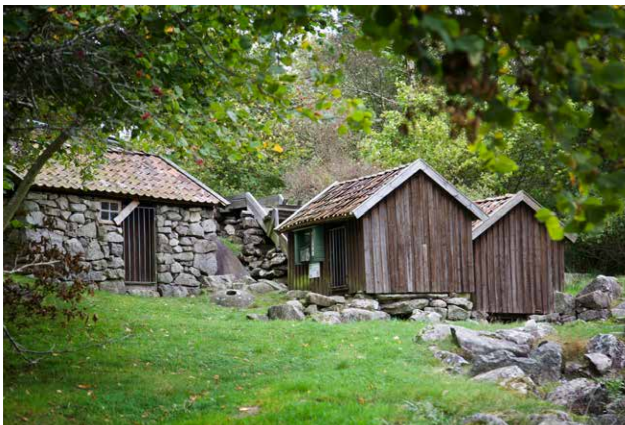
Kvernhusanlegg på Fuglestad. Foto: Lise Bjelland, 2021.
