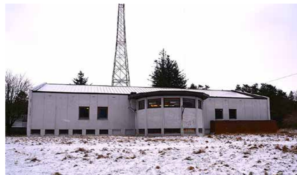
Radiostasjonen på Vigre. Foto: Hå kommune, 2023.
