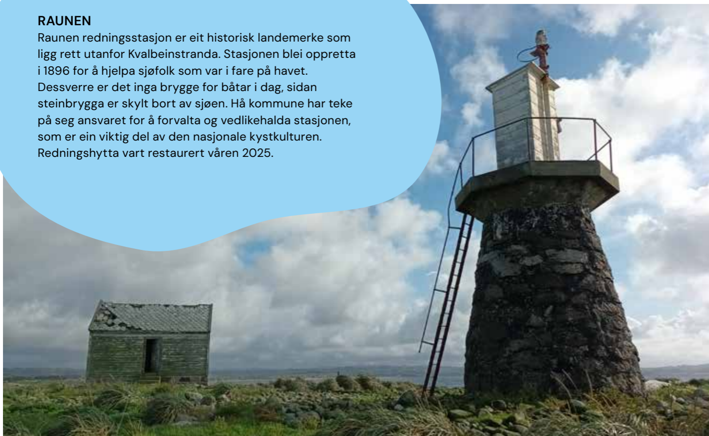
Raunen redningstasjon før restaurering. Foto: Hå kommune, 2023.
